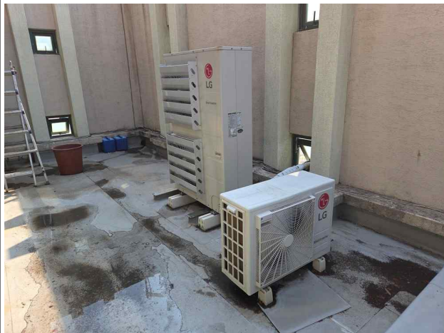
NO. 95 추가하중(실외기) 설치
