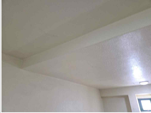
NO. 92 계단참 슬래브 균열 및 백화
