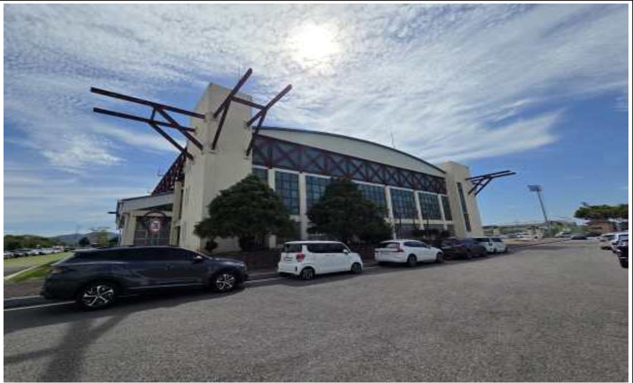
대상 시설물 좌측면부 전경
