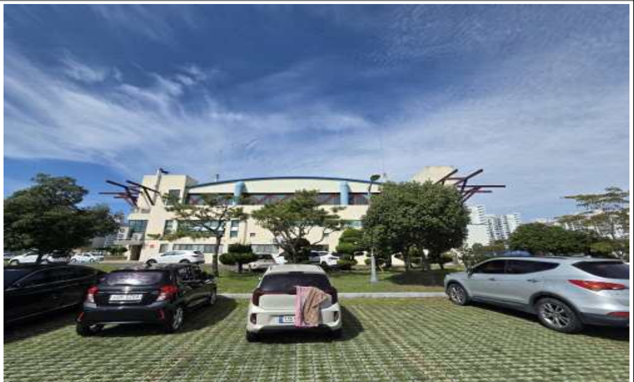
대상 시설물 우측면부 전경
