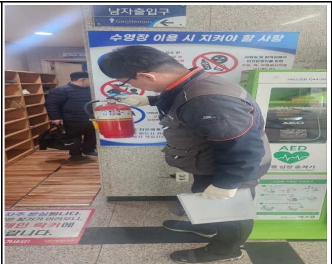
사진 설명 : 소화기 점검
