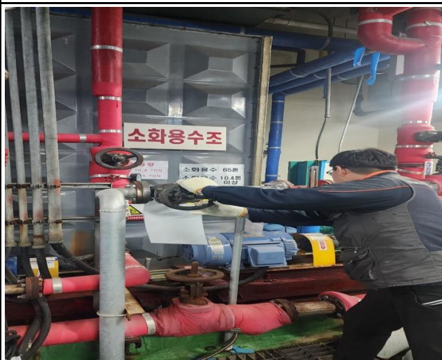
사진 설명 : 펌프실 펌프 점검
